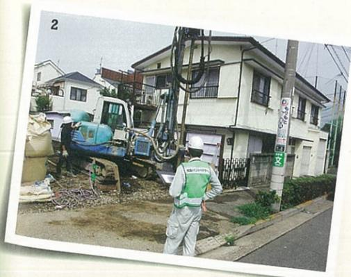
1. 情報を持たざる者である生活者に対し、的確な情報を提供して情報格差を解消することを目標に設立された地盤ネット。代表取締役の山本氏の志は高い 2. 地盤インスペクターによる地盤改良工事現場の第三者検査の様子
