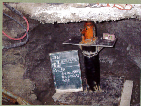
耐圧板工法の施工例。ジャッキアップした空隙には無収縮グラウト材などを圧入する（写真：地盤ネット）
