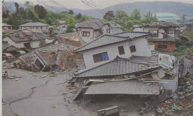
熊本地震で大きな被害を受けた益城町の中心部。地盤が軟らかい低地や傾斜地では、大半の住宅が倒壊した。2016年4月16日
